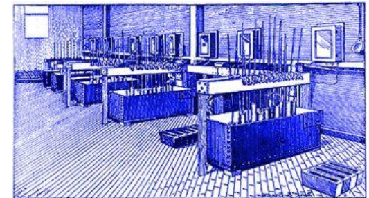
Piles de Hall pour la production d'Al
